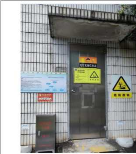
危险废物暂存间
